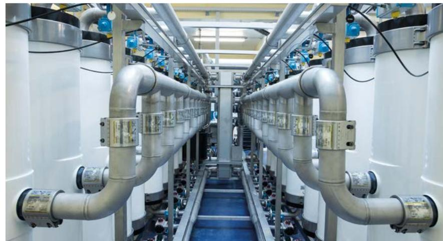
▲ La station de traitement de Chevilly (Excenevex) a permis de produire 1,1 million de m<sup>3</sup> d'eau potable (après prélèvement dans le lac Léman) grâce à son système d'ultrafiltration.
