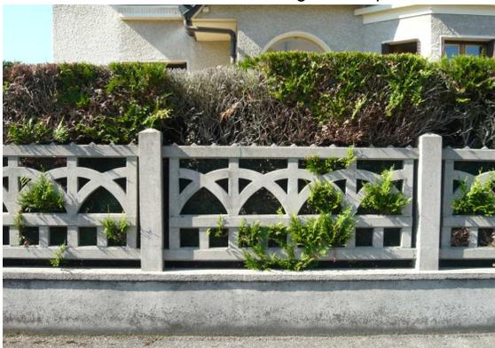
Mur maçonné en pierres surmonté d'éléments préfabriqués en béton et doublé d'une haie
