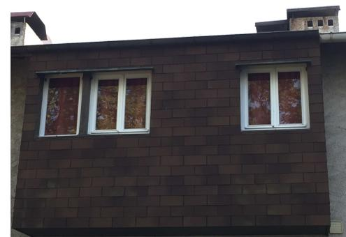
Menuiseries remplacées par un modèle à 2 vantaux
