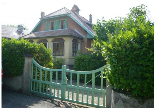
Mur maçonné surmonté d'une clôture de paline de bois arrondie en partie supérieure, posée dans le sens vertical
