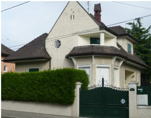
Mur maçonné surmonté d'éléments préfabriqués en béton, dessins géométriques
