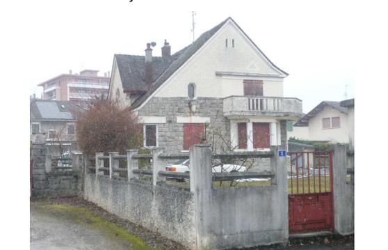
Muret béton et éléments préfabriqués en béton à dominance horizontale
