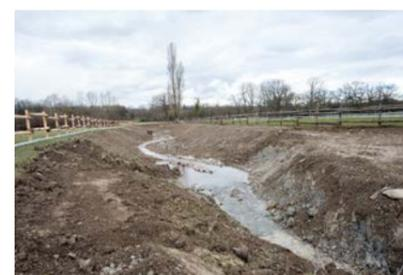
favorisant le retour de différentes espèces tels que les libellules et les amphibiens. Quant à la Bévière, son lit a été restructuré de façon plus naturelle, en aval de Sous-Etraz. Ces travaux de suppression des ouvrages vétustes et inutiles et de plantations d'arbres et d'arbustes le long du cours d'eau se sont accompagnés de la création d'un chemin piéton.
